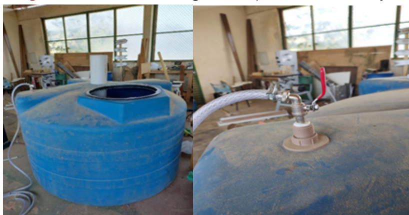
Figura 1 – Estrutura do biodigestor em processo de construção
