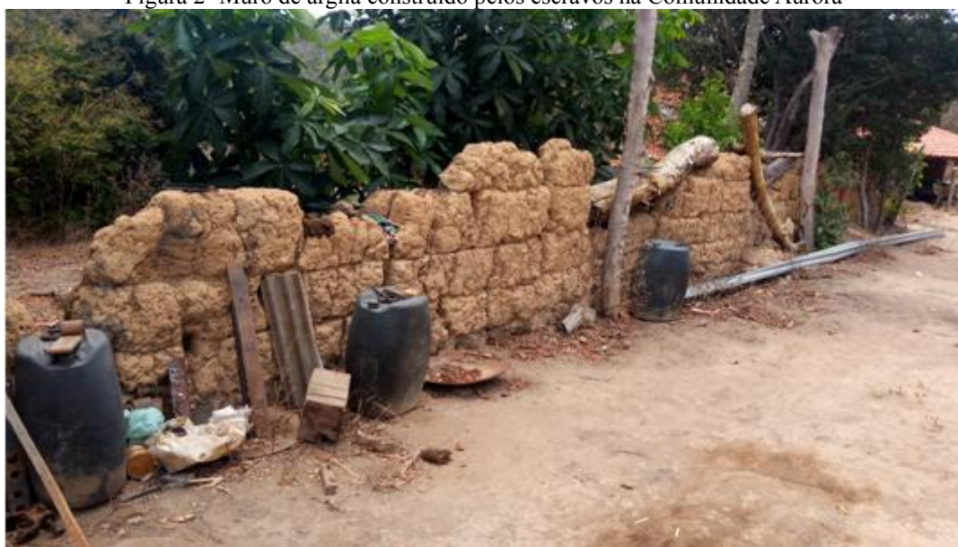
Figura 2- Muro de argila construído pelos escravos na Comunidade Aurora
