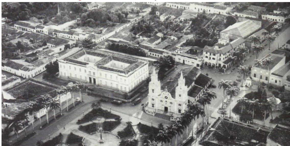
Figura 2: Palácio da Instrução, 1950–Cuiabá/MT.
